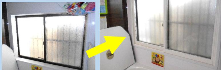
リビング掃き出し窓・リビング腰高窓・キッチン出窓・洗面所中窓・浴室窓の内窓(プラマードU)の設置とキッチン勝手口ガラスの断熱ガラスへの交換。内窓はLow-Eガラス。革新的窓リノベの補助金申請額213,000円 おおよそ半額が補助金で戻ってきます。補助金効果で注文が殺到して通常2~3週間で納品になるのが2か月もかかってしまいました。
